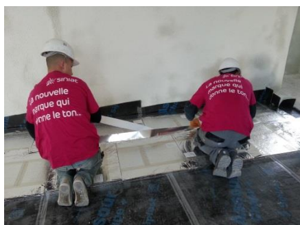
Pose de l'isolant sous vide en plancher sous chape
