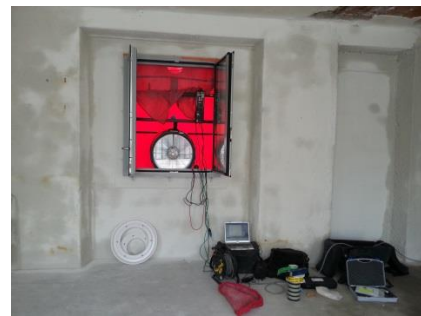
1 er test d'étanchéité à l'air
