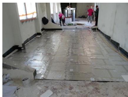
Pose de l'isolant sous vide en plancher sous chape
