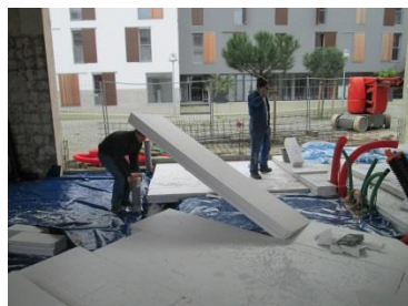
140mm d'isolant sous dallage et plancher intermédiaire en entrevous PSE avec traitements des abouts de dalle en périphérie.
