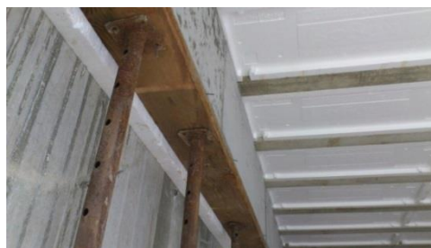
140mm d'isolant sous dallage et plancher intermédiaire en entrevous PSE avec traitements des abouts de dalle en périphérie.
